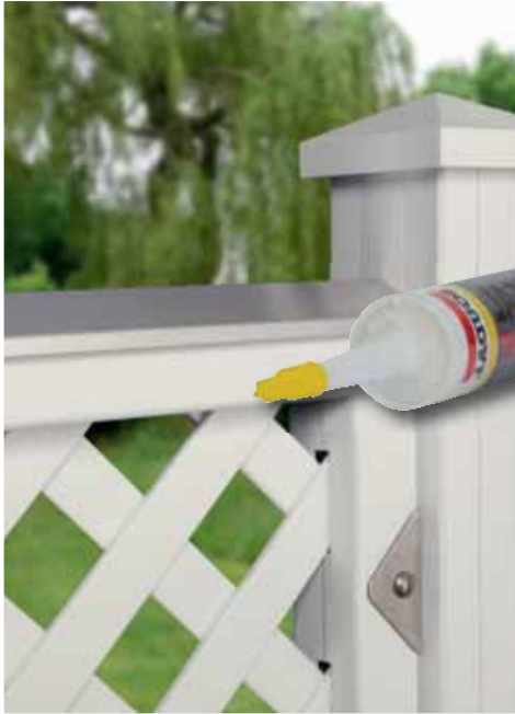
Designopzet Alu met MS-polymeerlijm (1398) bevestigen.
