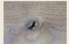
Uitbrekende kwasten en ruwe plekken aan kwasten
